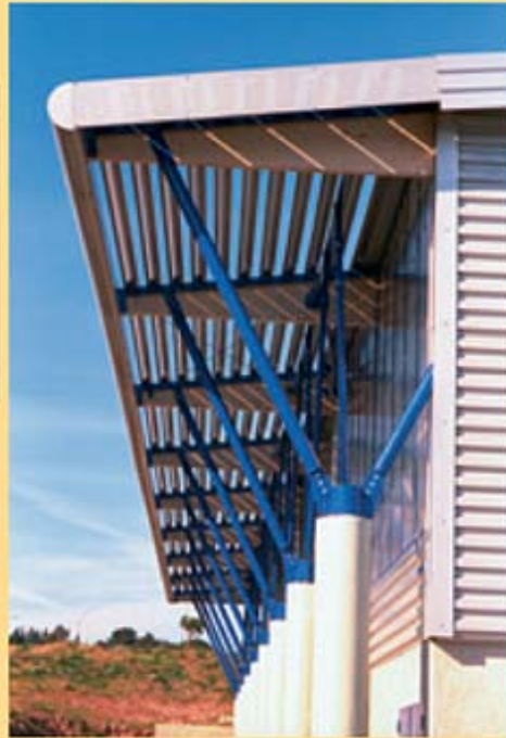
Duplex lackierte Kaltprofile verwendet als Sonnenschutzlamellen.
