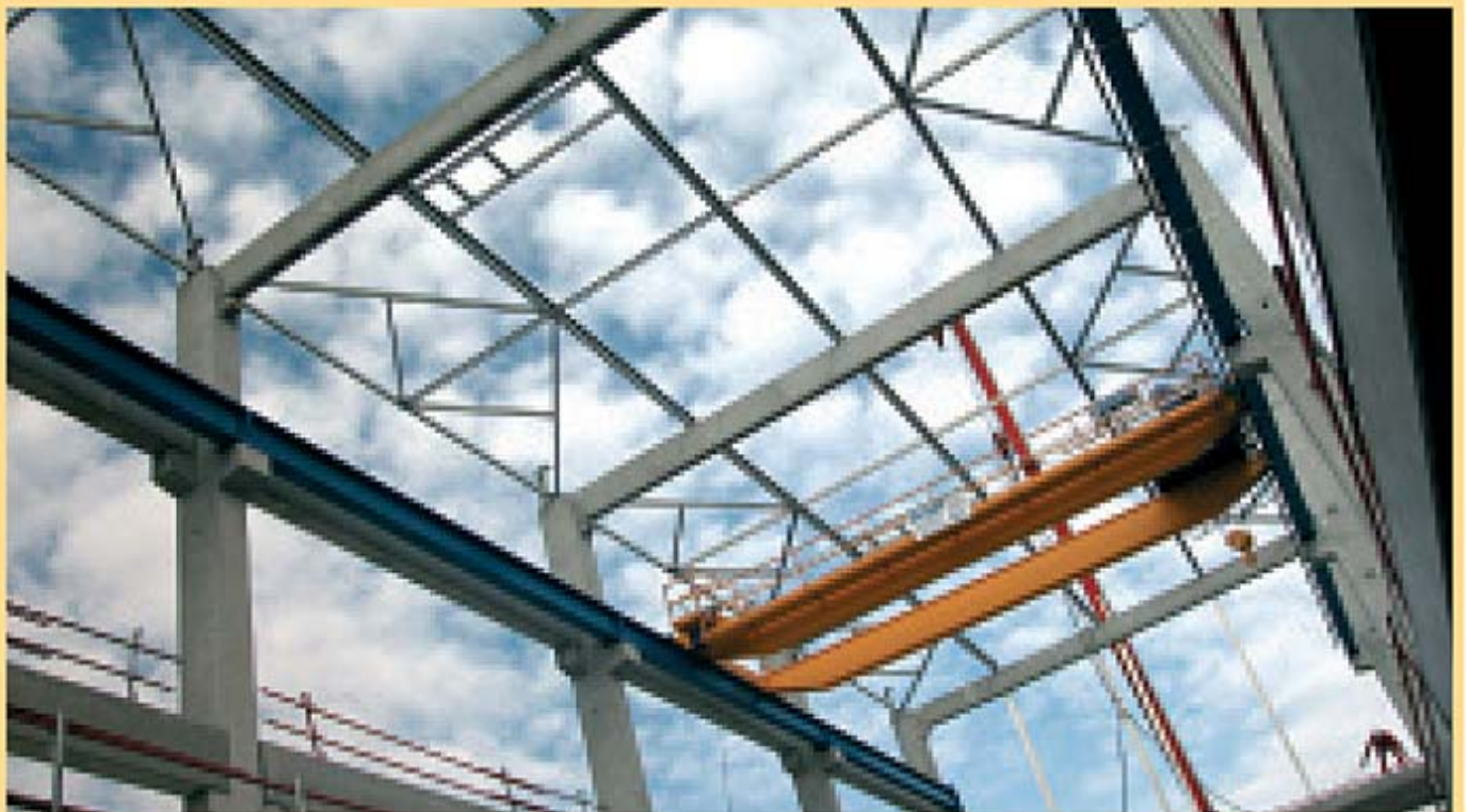
Kaltprofilpfetten und Abhängungen auf Betonunterkonstruktion.
