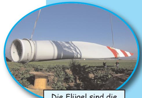
Die Flügel sind die längsten Einzelteile eines Windrades.
