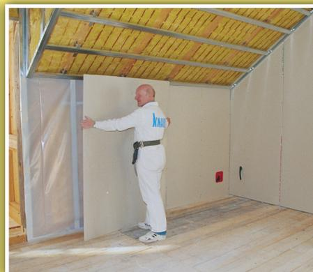
Feuerschutzplatte 15 mm:
